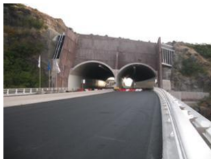
La tranchée couverte finie
